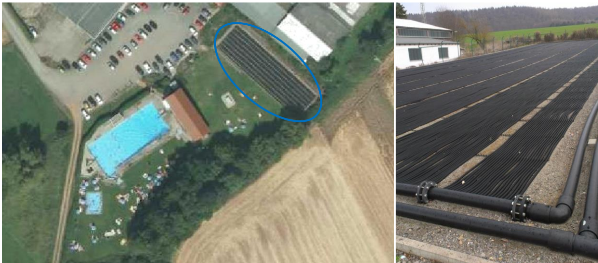
Abb. 15: Links: Luftbildaufnahme Freibad Berndorf mit Solarabsorberanlage [25]; rechts: Solarabsorberanlagen Freibad Berndorf im Detail [26]
